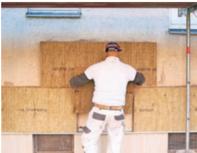
Eine Außendämmung legt sich wie ein Mantel um das Mauerwerk und schützt es so nachhaltig. FOTO: KLAUS-DIETMAR GABBERT
